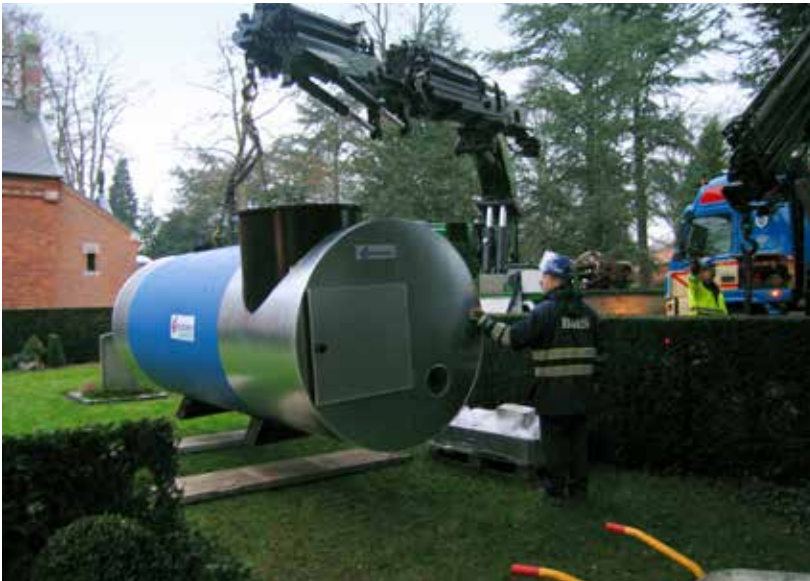
Røggaskøleren er på vej ind i den nye tilbygning til krematoriet i Svendborg
